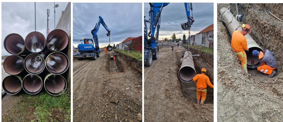
Abbildung 10: Impressionen der Verlegung von rund 150 m Rohrleitung für den Abwasserverband Thurau.
