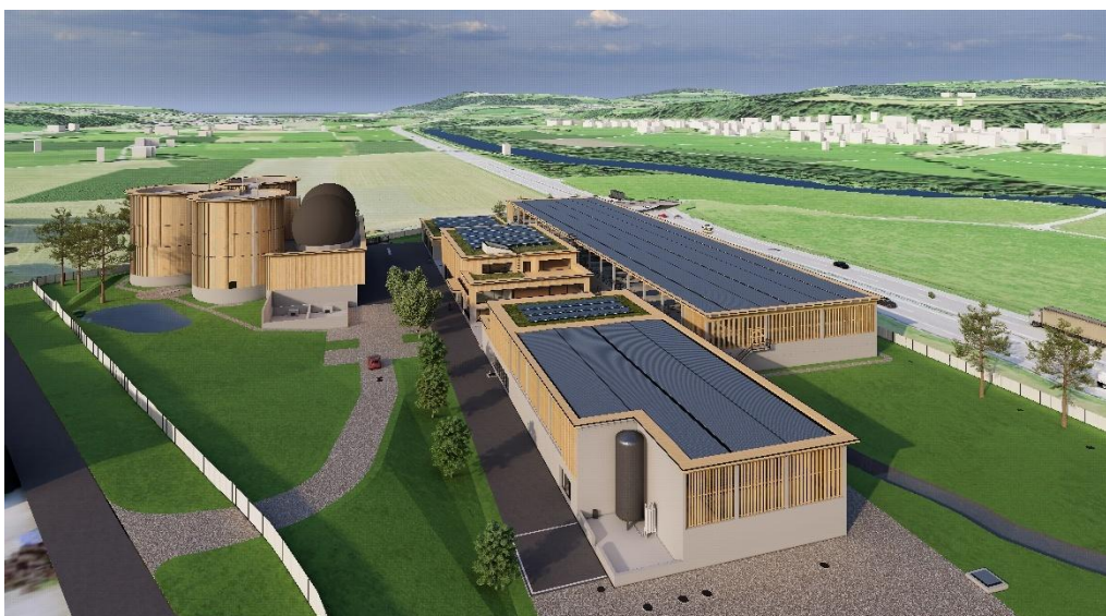
Abbildung 7: Ansicht der Abwasserreinigungsanlage ARA Thurau von Osten mit Blick in Richtung Wil.
